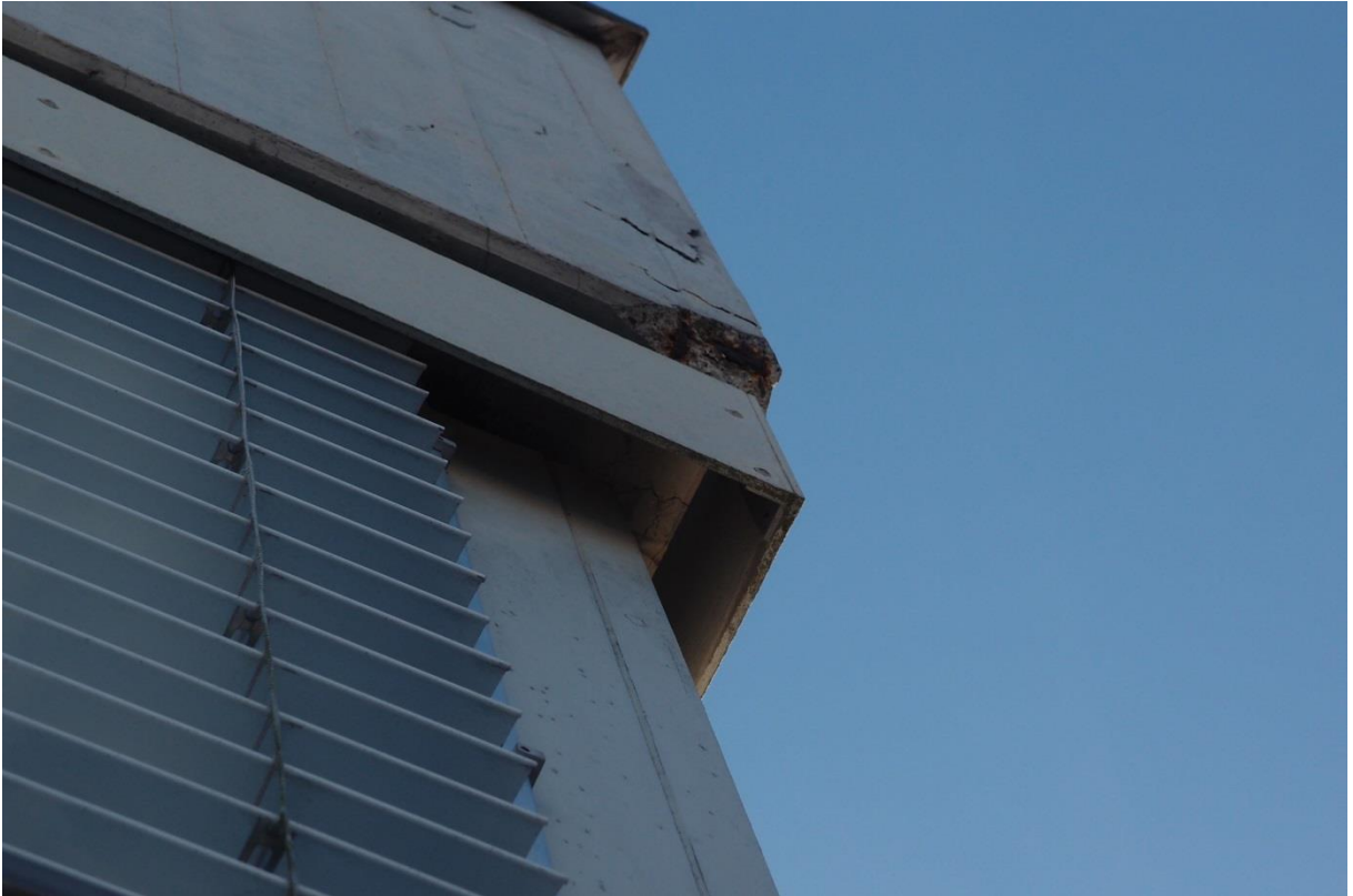
Abplatzungen Betonfassade
