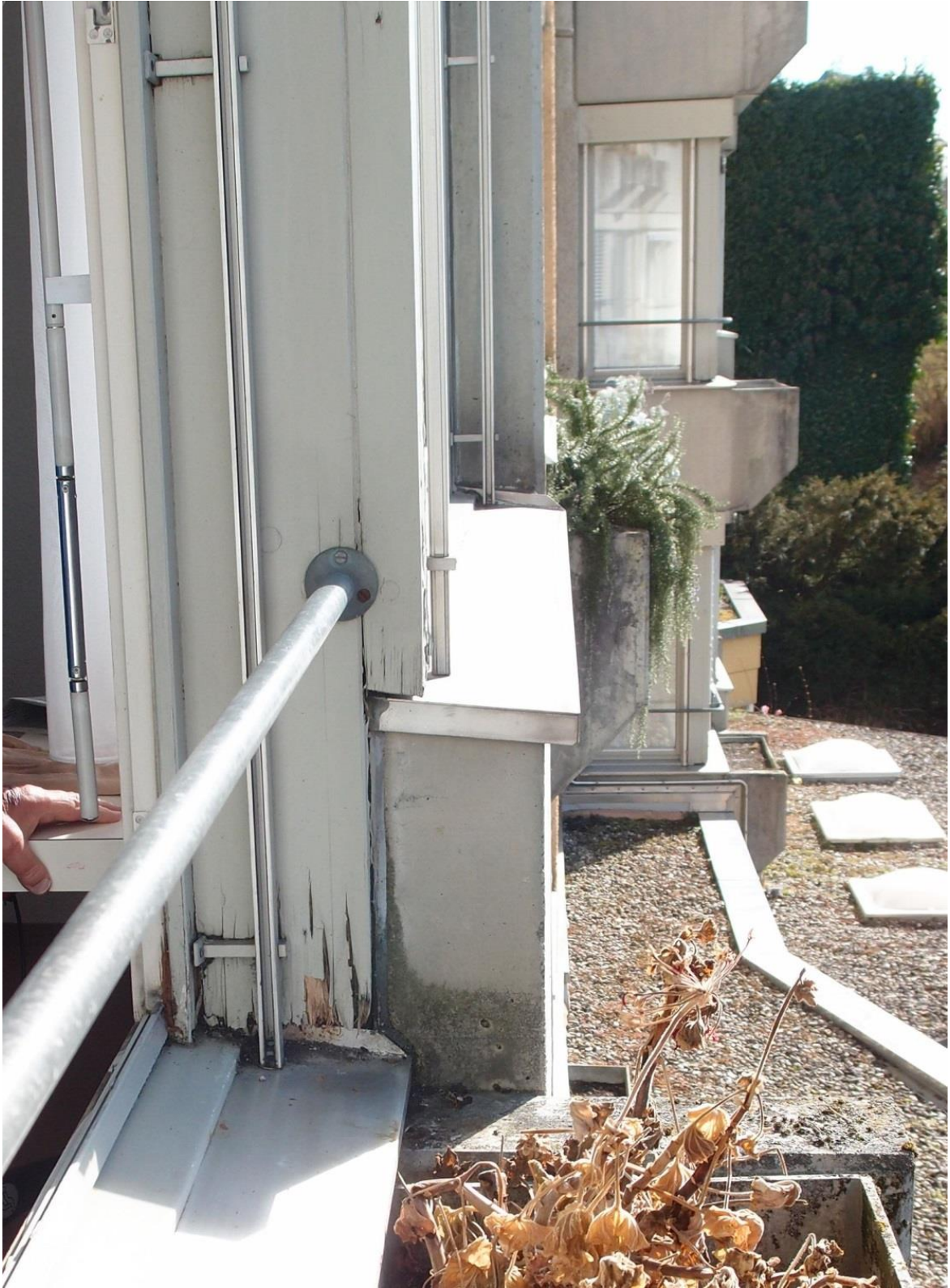
Undichte Aussenfassade
